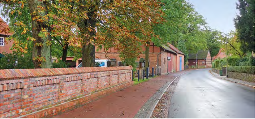
Die mit regionalen Felssteinen neugestaltete Kreisstraße
