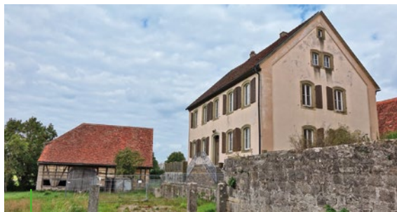
Am alten Pfarrhaus soll ein neuer Dorfplatz entstehen
