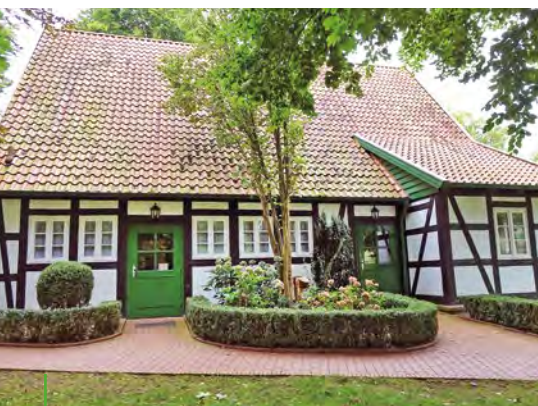
Das „Haus der Begegnung“ als neue Ortsmitte
