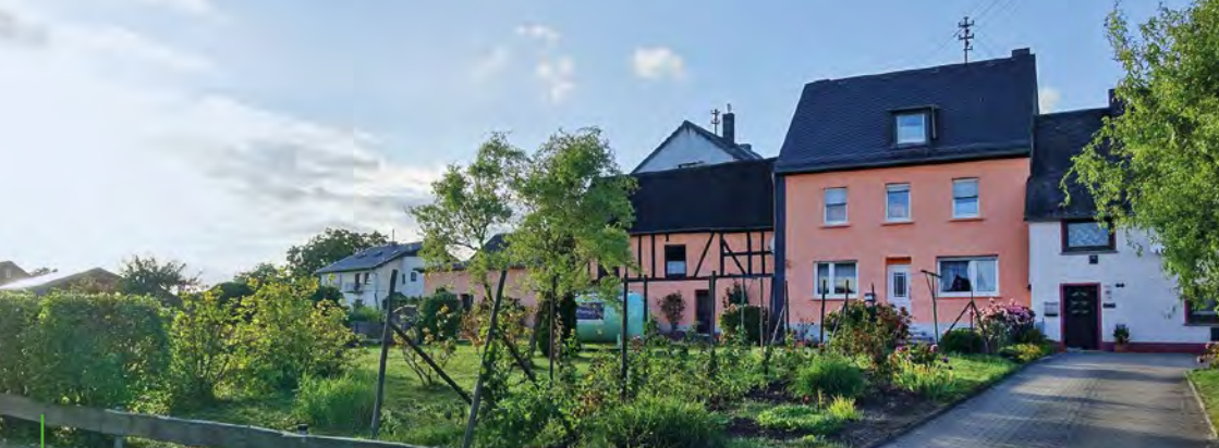
Ehemalige Hofstellen prägen das Ortsbild
