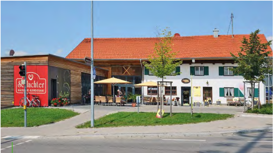
Nahversorgung im sanierten Keeshof
