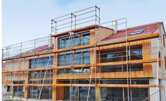
Ein Reihenhaushaus in der Bauphase
