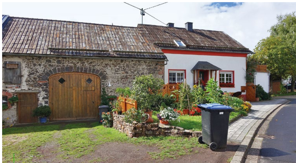
Ein Beispiel für die zahlreichen Sanierungsmaßnahmen
