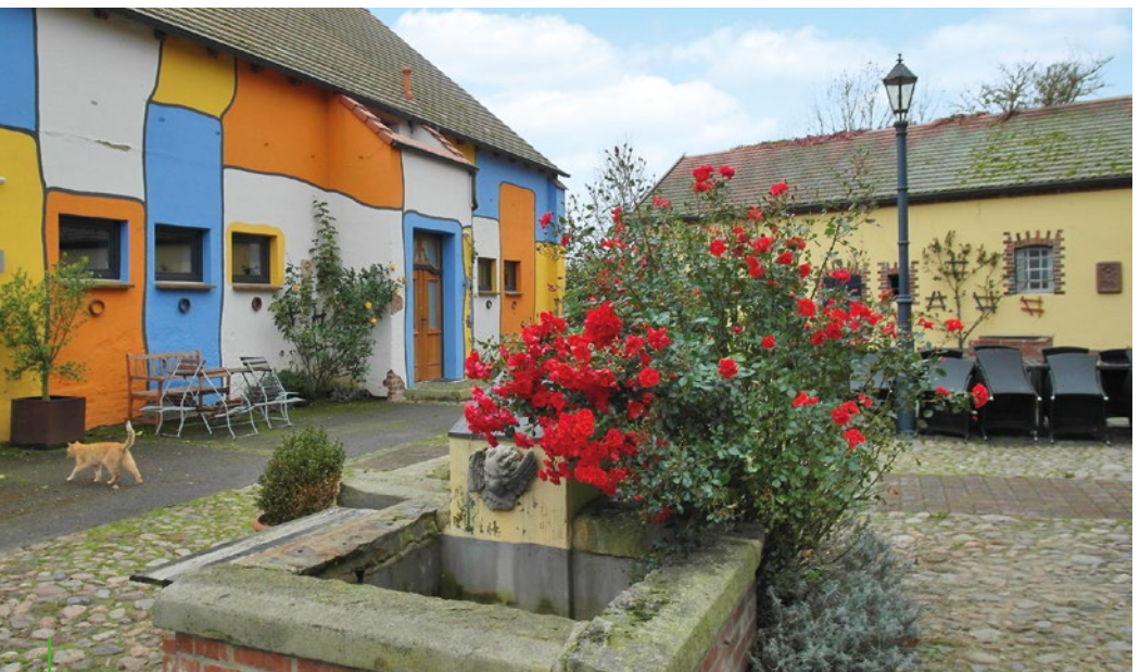
Der sog. „KulturHof“ ist als Seminarhaus in einem ehemaligen Stallgebäude entstanden
