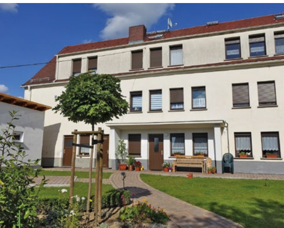
Private Investoren schaffen im alten Kindergarten neuen Wohnraum
