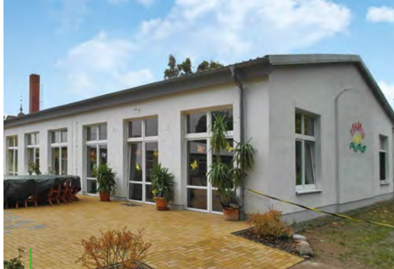
Neue Nutzung der ehemaligen LPG-Gebäude durch eine Schule in privater Trägerschaft
